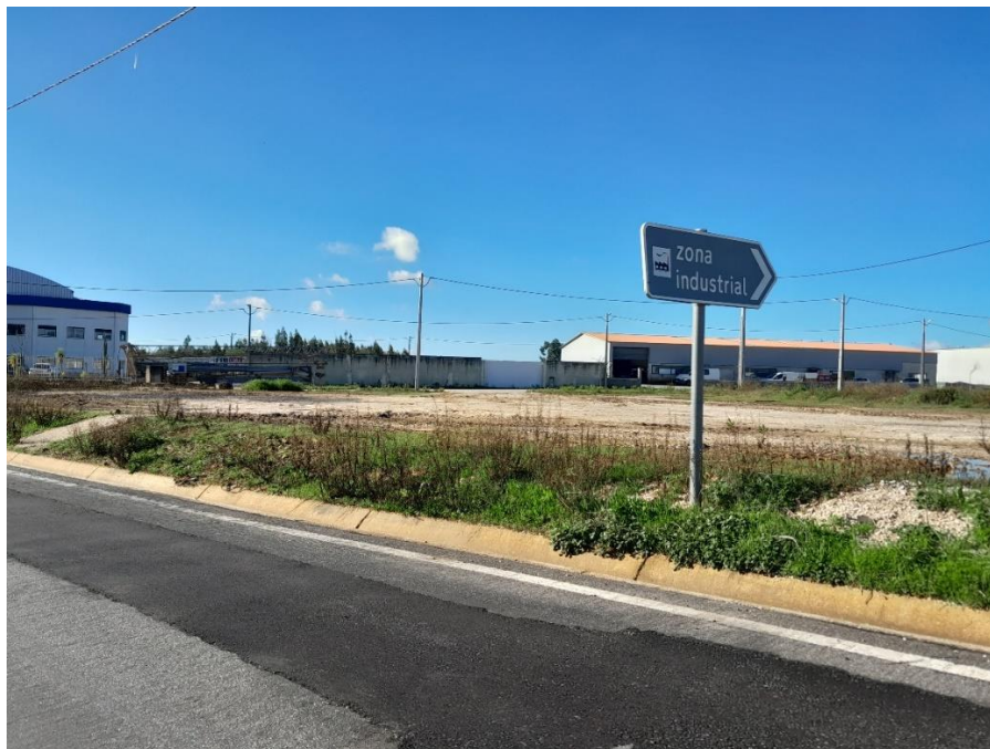
Figura 21. Zona industrial do Pinheiro do Bordalo - empresas em operação e repavimentação parcial de via concluída na sequência da implementação de rede de saneamento.
